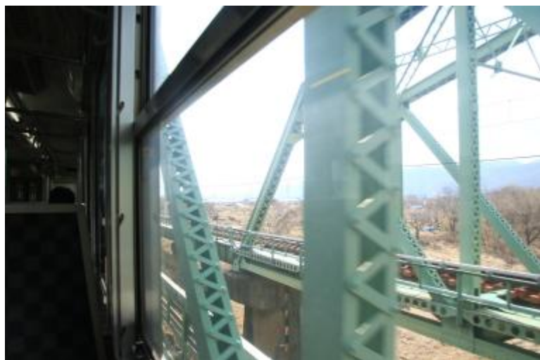
犀川橋梁を通過
