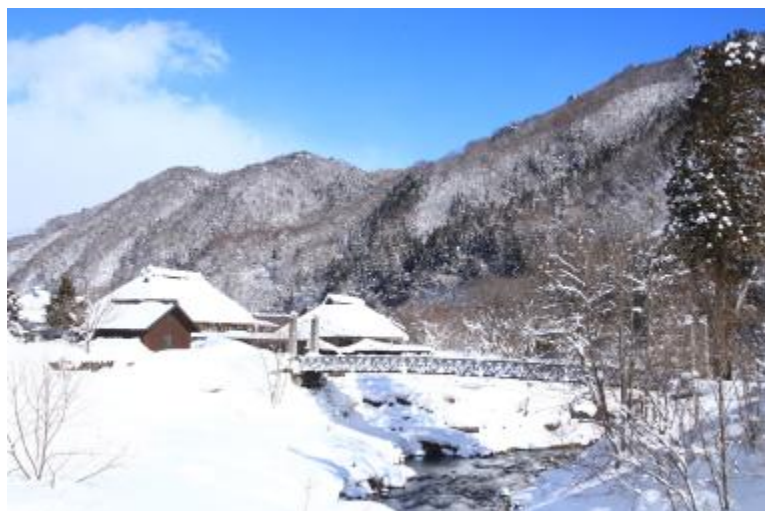
大出の吊り橋
