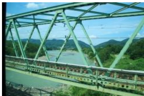
犀川橋梁を通過
